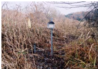
●2002年12月5日 設置された地下水位計
