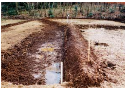
●2002年12月26日 土堰堤（畦）の整備直後
