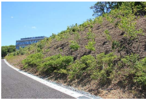
●2013年5月2日 大久保山造成法面
