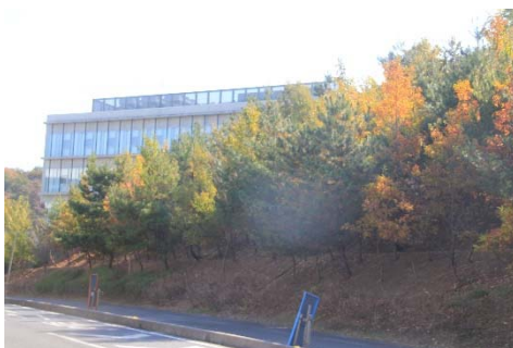
●2020年11月13日 大久保山造成法面
