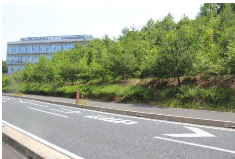
●2018年6月8日 大久保山造成法面
